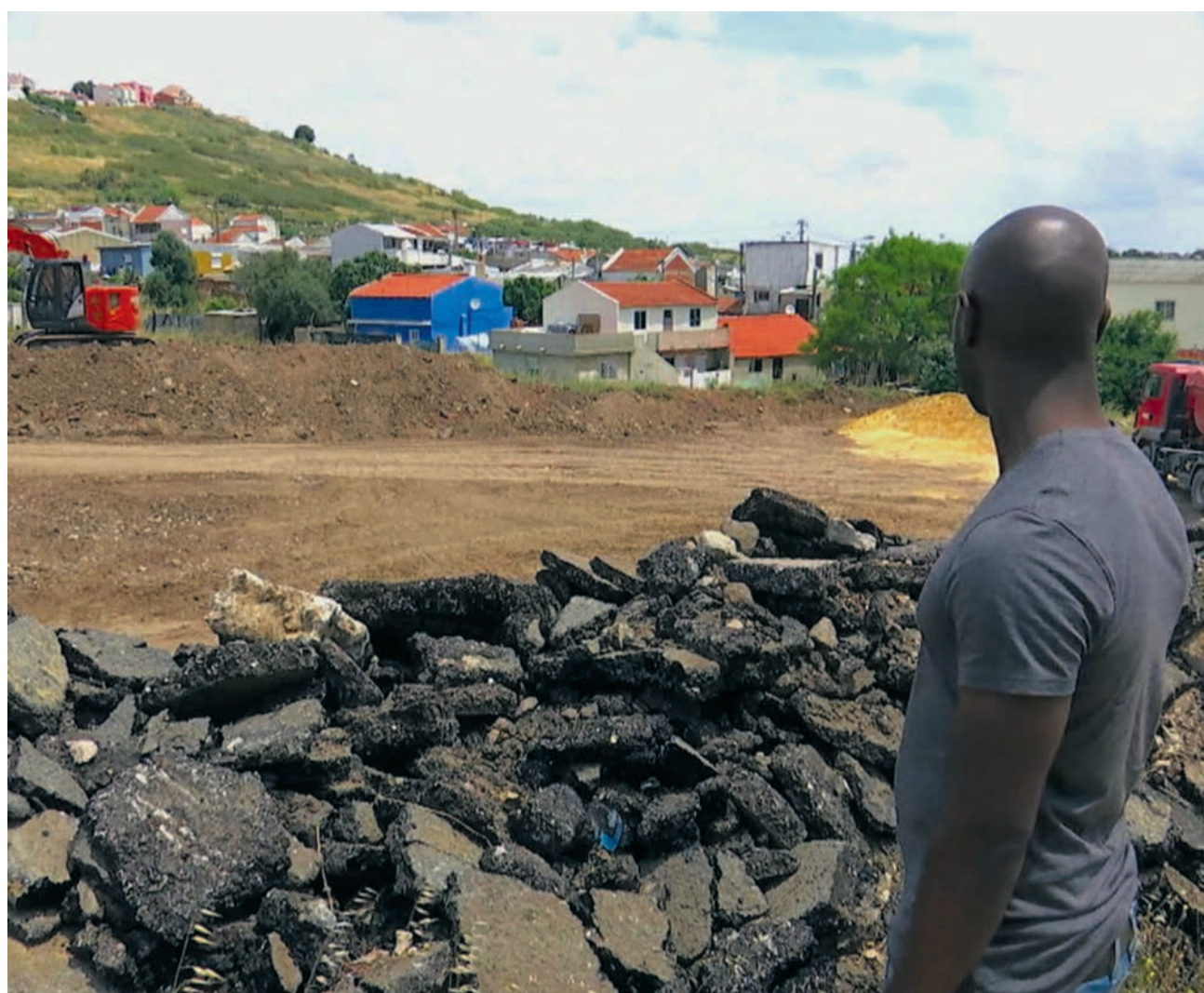
Morador observa demolições no bairro da Quinta da Lage
